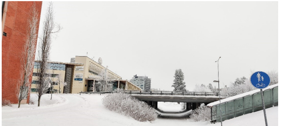
Kuva 25: Valokuva Ahvenniitynraitin alikulkukäytävästä, kuvattu tammikuussa 2021.
